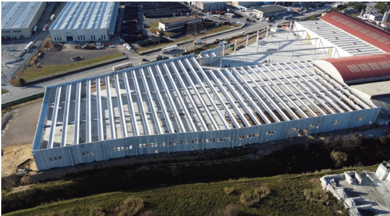
L'industria cartiera Progest (gruppo ZAGO) è in costruzione con grandi maglie strutturali e spessori molto ridotti del sistema trave/solaio. L'edificio viene costruito in aderenza ad uno storico edificio industriale esistente.
