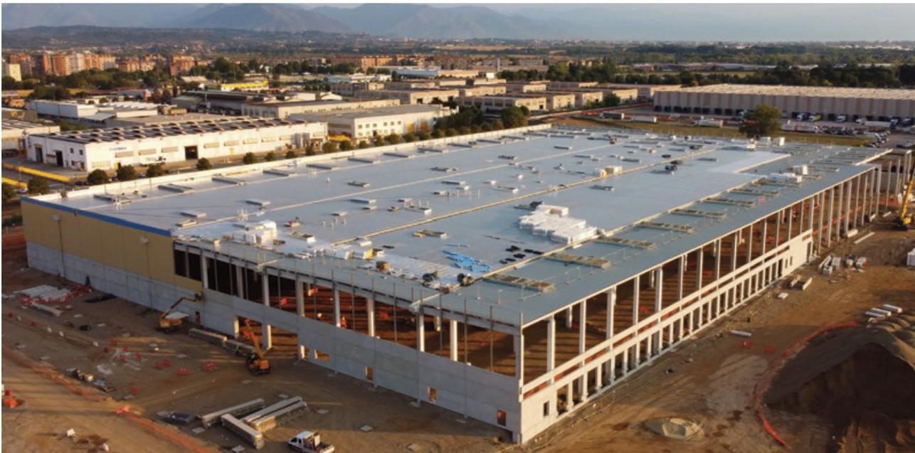
Il Polo logistico di Orbassano si estende su un'area di circa 40.000 metri quadrati ed è stato costruito con caratteristiche uniche in Italia a livello energetico e di impatto ambientale. In particolare i pannelli di tamponamento del magazzino, degli uffici e dei truckers Lounge sono stati realizzati con uno spessore adatto per avere un coefficiente U pari a 0,19 W/mqk.
