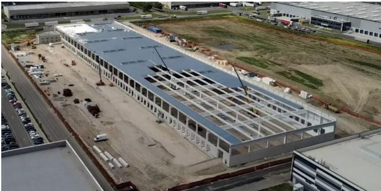
In nove settimane dalla conferma d'ordine abbiamo terminato la progettazione, produzione e montaggio delle strutture prefabbricate (compresa palazzina uffici e vano scala altezza 13,50 mt.) con pannelli divisorii e di tamponamento. Sono state poste in opera anche 34 travi di lunghezza pari a 30,00 ml.
