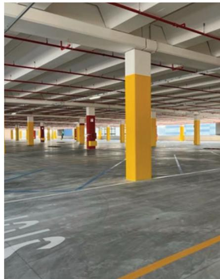
Il grande parcheggio per i Van elettrici (il primo in Italia) si estende su una superficie di circa 29.000 mq con lunghezze dei solai pari a 17,25 metri e pannelli esterni calcolati per resistere all'urto di un Van a piano carico.
