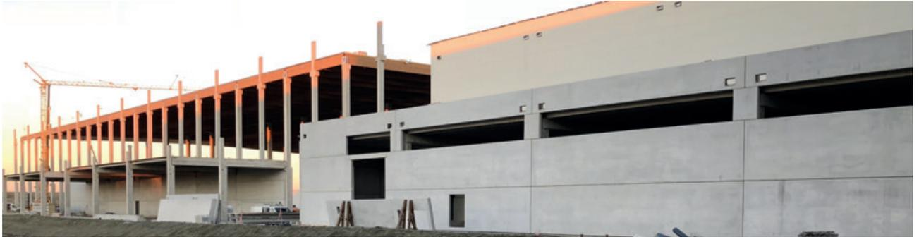
Il centro logistico Interspar (Aspiag Ag) è un intervento non tradizionale, con altezze fino a 24 ml. e strutture prefabbricate in calcestruzzo abbinate a strutture orizzontali in legno lamellare ed oltre 18.000 mq. di soppalchi anche con grandi carichi. Le pannellature sono di molte tipologie tra cui elementi realizzati con matrici speciali francesi.
