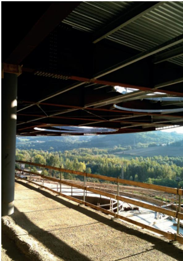
La cantina di Cortona si è sviluppata su una superficie di 45.000 mq. e luci 20x20 ml. con sovraccarichi superiori ai 500 kg/mq per la presenza di terreno vegetale e vigneti dimostrativi, mentre la spettacolare cantina di Bargino è stata realizzata all'interno di una collina (circa 60.000 mq. superficie coperta) con edifici complessi di più piani realizzati sia in calcestruzzo che in acciaio, prodotto usato anche per realizzare parti architettonico/strutturali.
